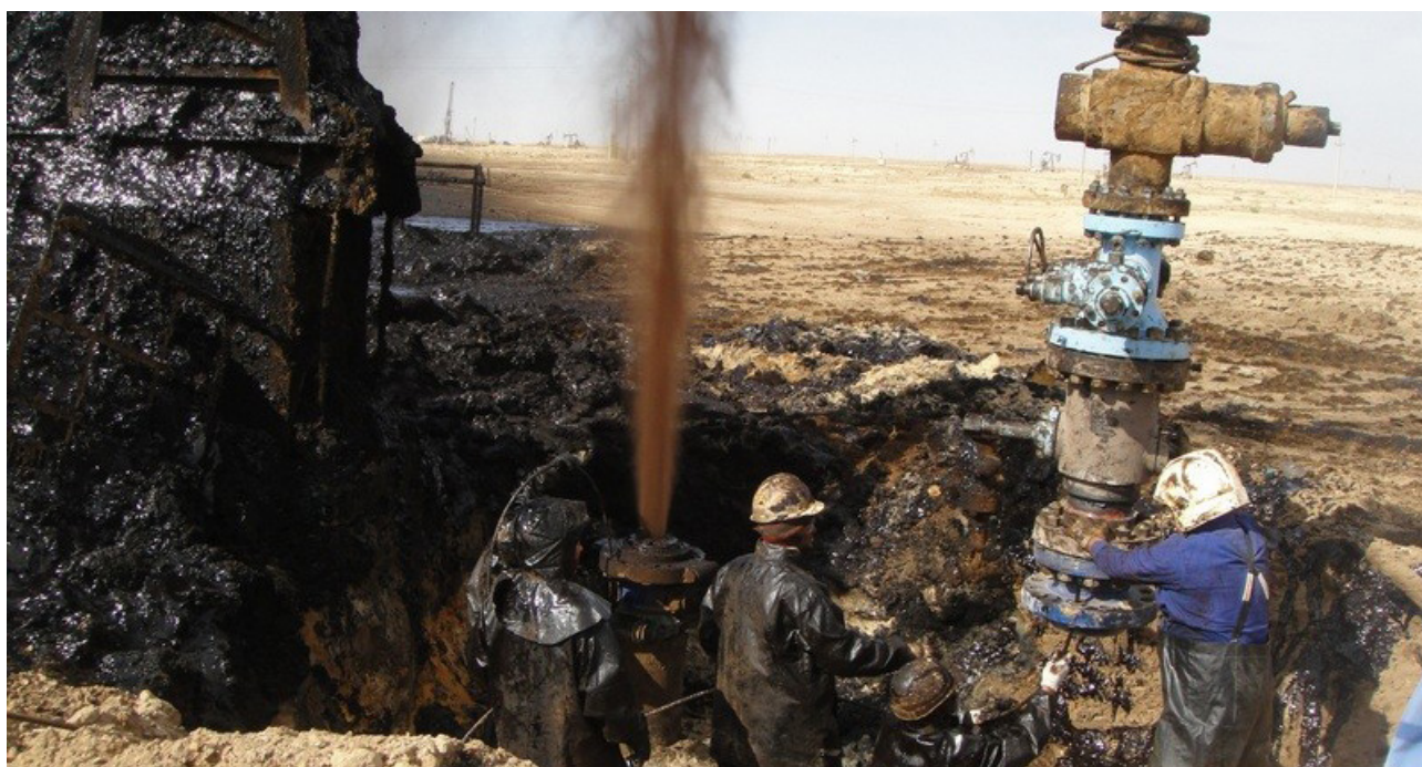
Рис. 100. Аварийное фонтанирование скважины [www.lada.kz]
