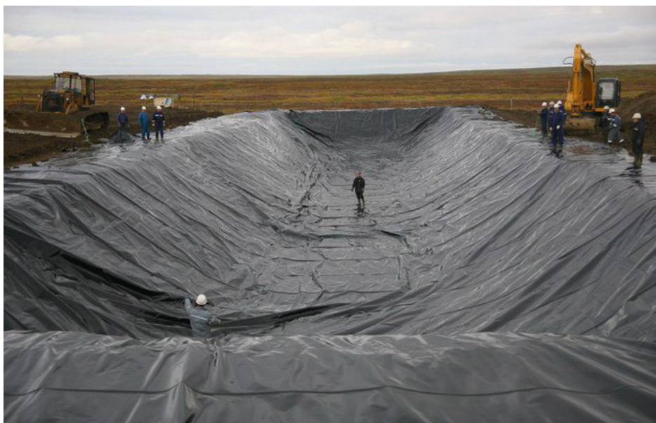
Рис. 91. Сооружение земляного амбара с гидроизоляцией [rosneftemash34.ru]
